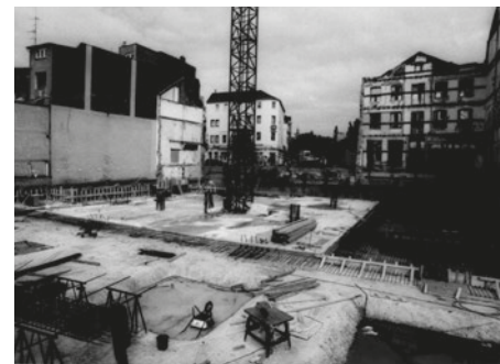
In der Bergisch Gladbacher City beginnt der Bau des Böhm-Baus, in das Peek & Cloppenburg einzieht.
