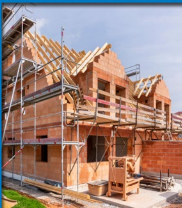
Bauplanung: Von der Idee über den Entwurf bis zum Rohbau
