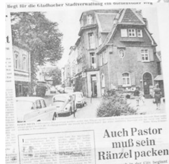
Kölnischer Anzeiger Juni 1973: In der Laurentiusstraße plant die katholische Pfarrgemeinde den Abriss der vorderen Häuser für ein Gemeindezentrum.
