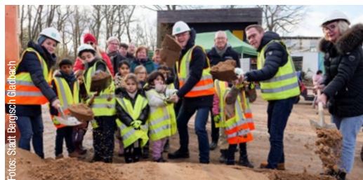
Spatenstich mit Grundschulkindern: Der Bau der neuen GGS in Bensberg hat begonnen.
