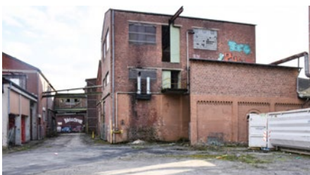
Relikte einer Autowerkstatt, die hier zwischenzeitlich residierte.
