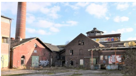
Links das alte Kesselhaus und der Schornstein, im Hintergrund der achteckige Wasserturm.
