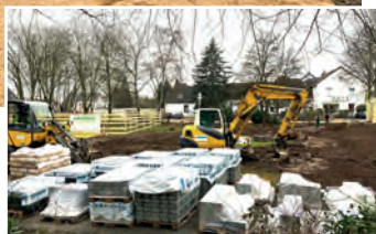
Noch ist der Mehrgenerationenpark eine Baustelle.
